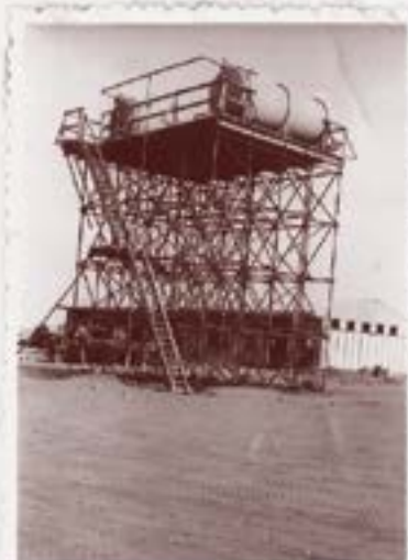
Chateau d'eau provisoire 20 m3 . Derrière : Bâtiment cuisines "Durélie"
