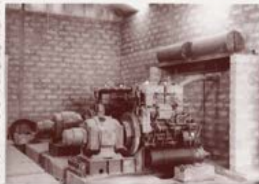
Centrale Electrique provisoire Deux premiers groupes Alsthom 69 K.V.A.
