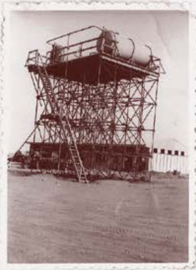
Chateau d'eau provisoire 20 m3 . Derrière : Bâtiment cuisines "Durélib"
